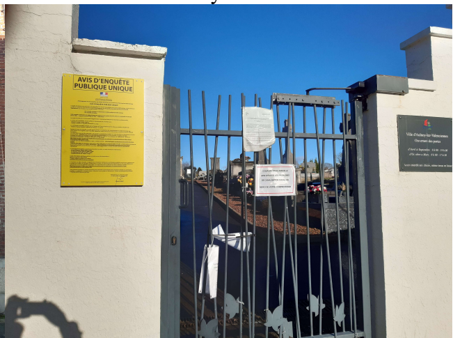
Abords du cimetière rue du Pont d'Aulnoy
